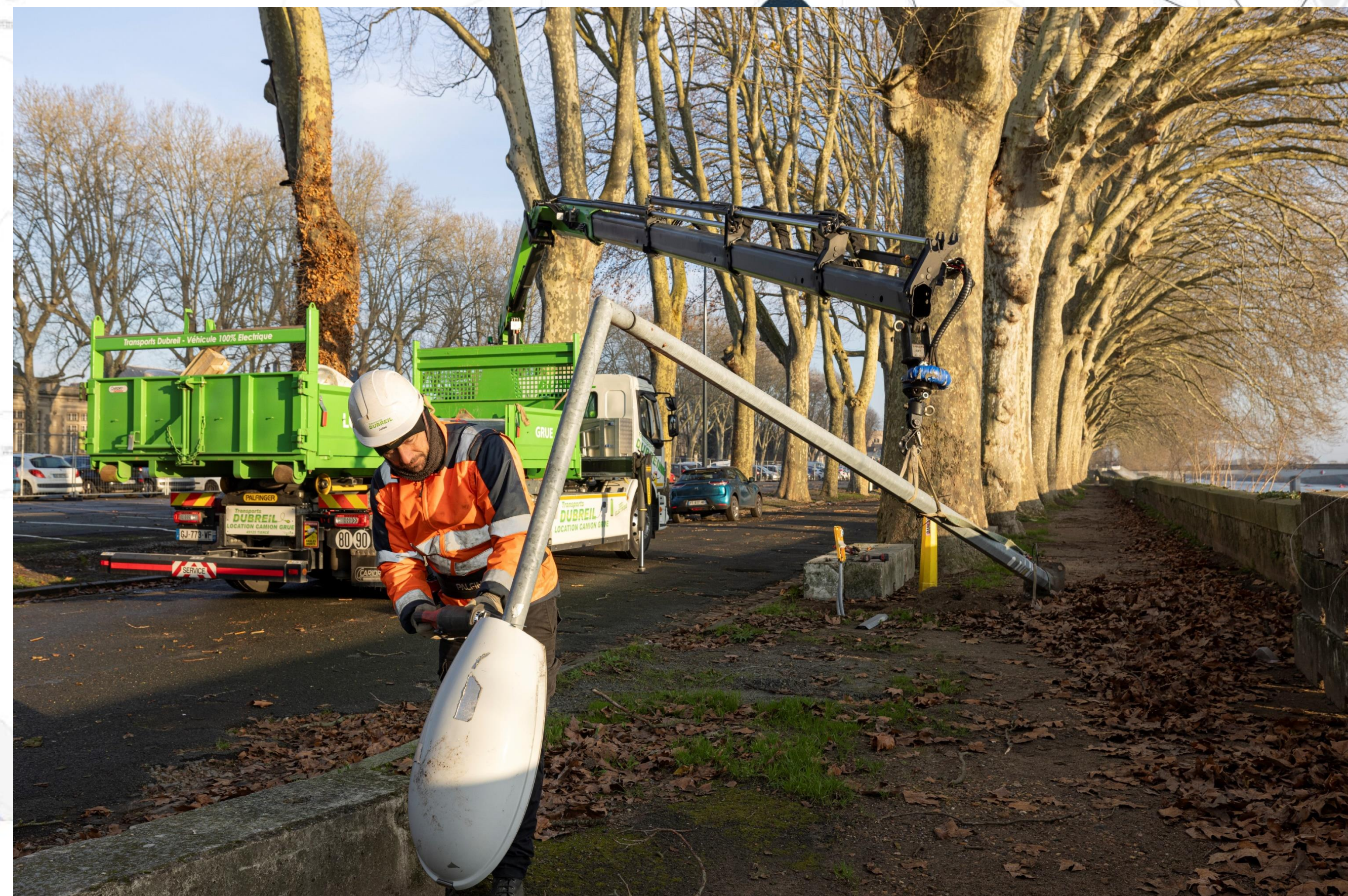
Dépose pour rénovation d'un mât d'éclairage public sur Angers Loire Métropole. Photo: crédit T.Bonnet
