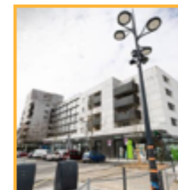
Travaux TI sur l'éclairage public
