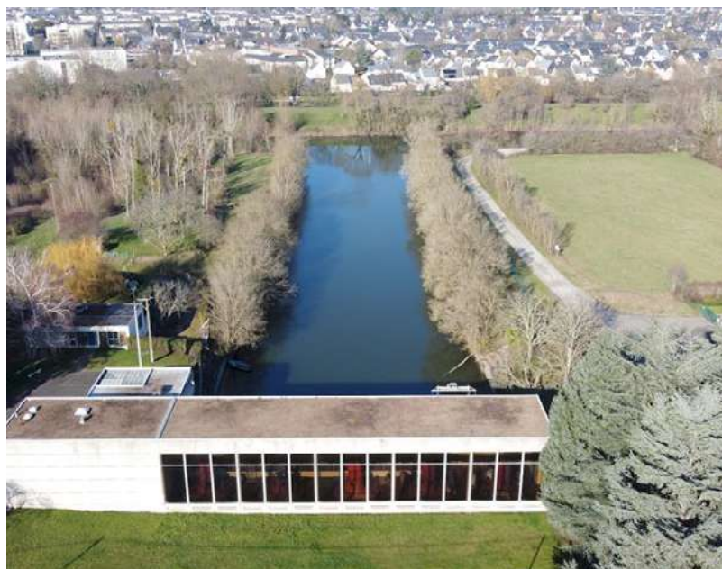
© Directeur station d'exhaure, Station d'exhaure Les Ponts de C
