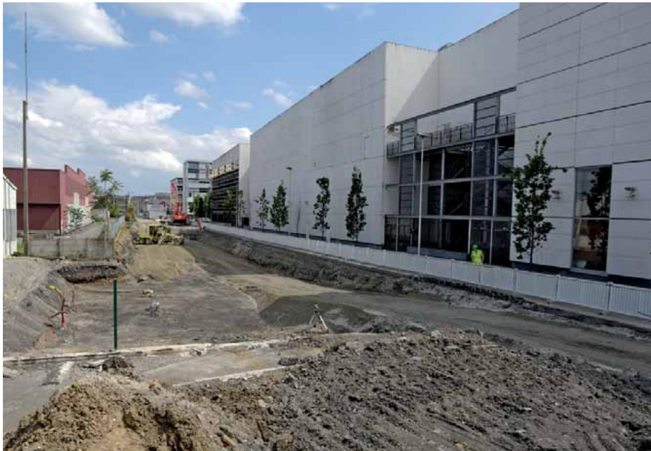
Début juin 2008, débutera la réalisation de nouveaux remblais servant à offrir un accès sécurisé des engins et des personnels sur les sites de réalisation des fondations de l'arc, en berges de Maine. Ces remblais seront retirés de la Maine en fin de chantier.
