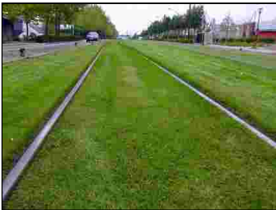
Végétalisation « classique » de tramway sous forme de pelouse de graminées, ici exemple de Nantes (Crédit photo : Olivier Damas-Plante & Cité)
