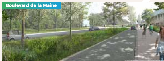
▲ Vue du boulevard, après le pont Confluences, en direction du pont Jean-Moulin.
