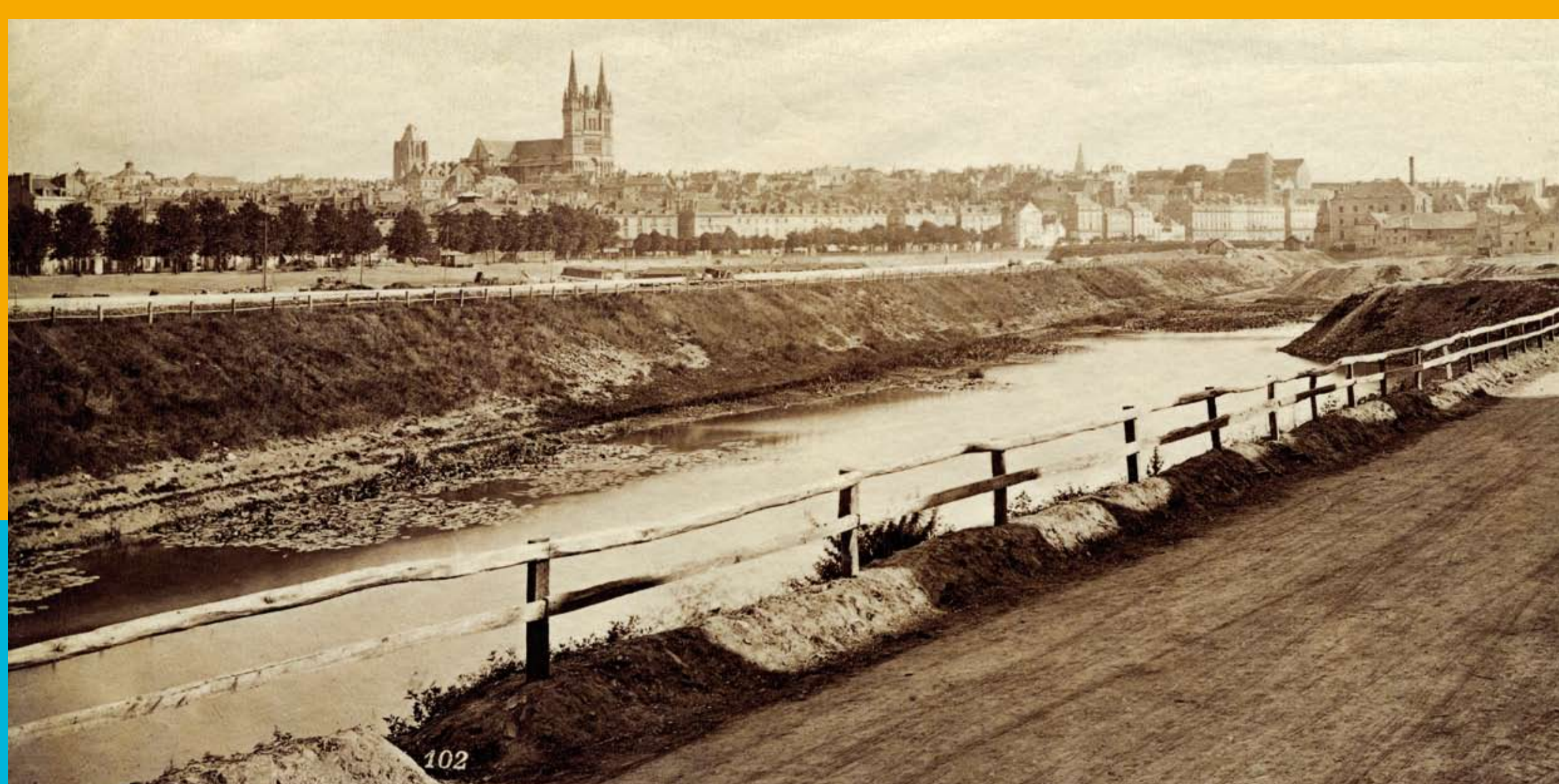
La boire Saint-Jean, face à l'hôpital Saint-Jean, en cours de remblaiement pour réalisation de la place La Rochefoucauld, vers 1881-1885. Les barrières garde-fous ont été posées en 1881.
