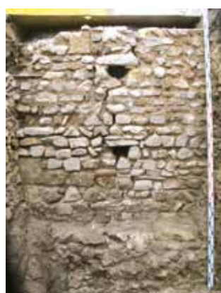
Mur du pignon du grand édifice du XI e siècle. © Martin Pithon, Inrap
