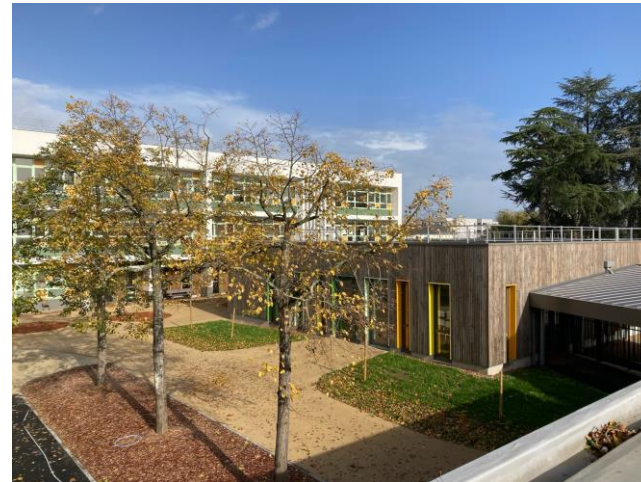
Photo : Groupe scolaire Gérard Philippe après travaux, en 2023
