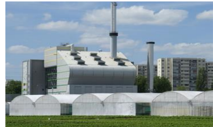
Chaufferie en cogénération Biowatt
